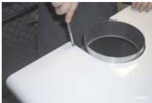
Рис. 3 - Выкрутите два винта - самореза 2, удерживающих крышку котла.
